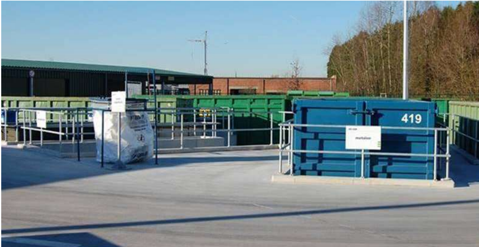
IGEAN recyclagepark met verzonken containers
