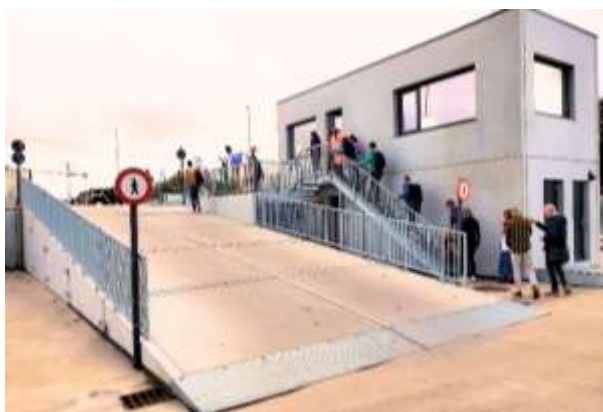
xi toegang platform recyclagepark Oostende, onder het verhoogde platform zijn extra opslagmogelijkheden.
